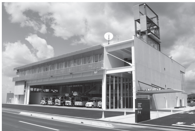
写真1 新消防庁舎。防災拠点も兼ねる
