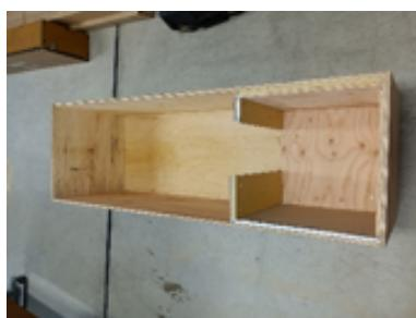
写真 2-3 燃焼室の内張りが完成した状況
