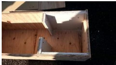
写真 2－1 燃焼室に石膏ボードを張り付けた状況
