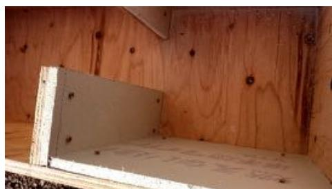
写真 2－2 燃焼室「床面」、「立ち上がり」の石膏ボードの張り付け状況
