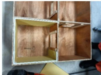
写真 2-6 A 室の内側に石膏ボードを張り付けている様子
